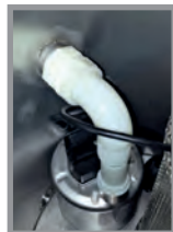
A l'intérieur de la cuve
