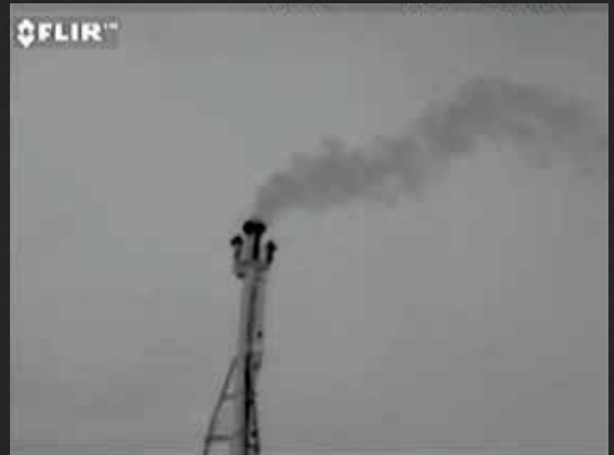
VISUALISEZ CLAIREMENT LES FUITES D'HYDROCARBURES
