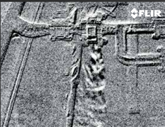
IDENTIFIEZ LES FUITES DE CO 2 DIFFICILES À LOCALISER
