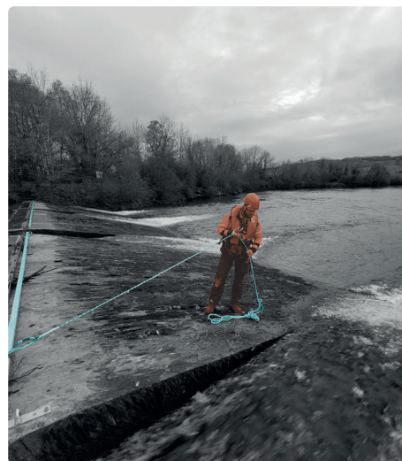
Gestion de projet pour la sécurisation de barrages à aiguilles poçur les VNF .
