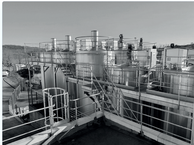
Conduite de projet pour la sécurisation des interventions sur et dans des cuves ALIMENTAIRES.
