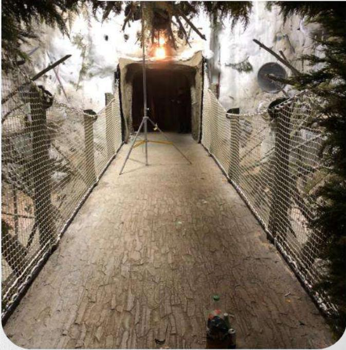
Filet de sécurité EN 1263-1 mailles de 50mm diamètre 4.75mm découpées en mailles carrées en tresse polyamide blanche haute ténacité, équipé d'une ralingue en polyamide blancs haute ténacité diamètre 12mm passée entre toutes les mailles et entièrement cousue au pourtour du filet l'ensemble ignifugé
