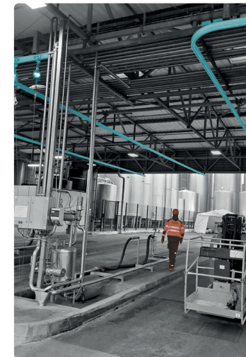
Mise en service de 7 LDV antichute, sécurisant les camions citernes chez un INDUSTRIEL LAITIÈRE .
