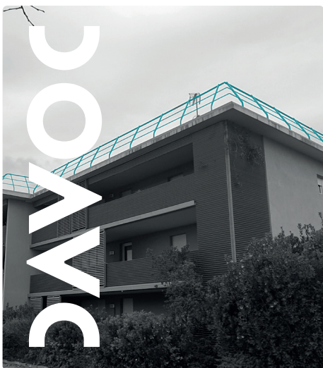
Réception des gardes corps thermolaqués sur les toitures terrasses d'un BAILLEUR SOCIAL .
