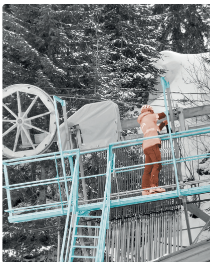
Mise en service des moyens d'accès et passerelles, d'un TK en STATION DE SKI .
