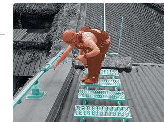
Mise en service d'une sécurisation complète, sur les toitures d'une MAIRIE .
