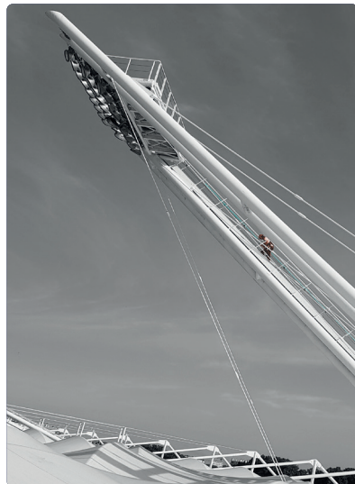
VGP de LDV rails antichute sécurisant l'accès aux éclairages du STADIUM de Toulouse .
