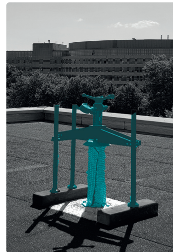
Test, non destructif, d'un potelet d'ancrage sur toiture terrasse bitumineuse d'un BÂTIMENT PUBLIC .
